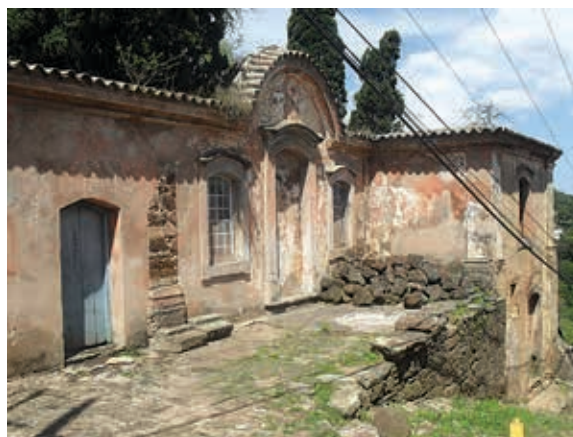
Figura 3 - Atuais ruínas das instalações onde funcionou o Hospital Real de Vila Rica, em Ouro Preto, à Rua Henri Gorceix (antiga Rua Nova).
